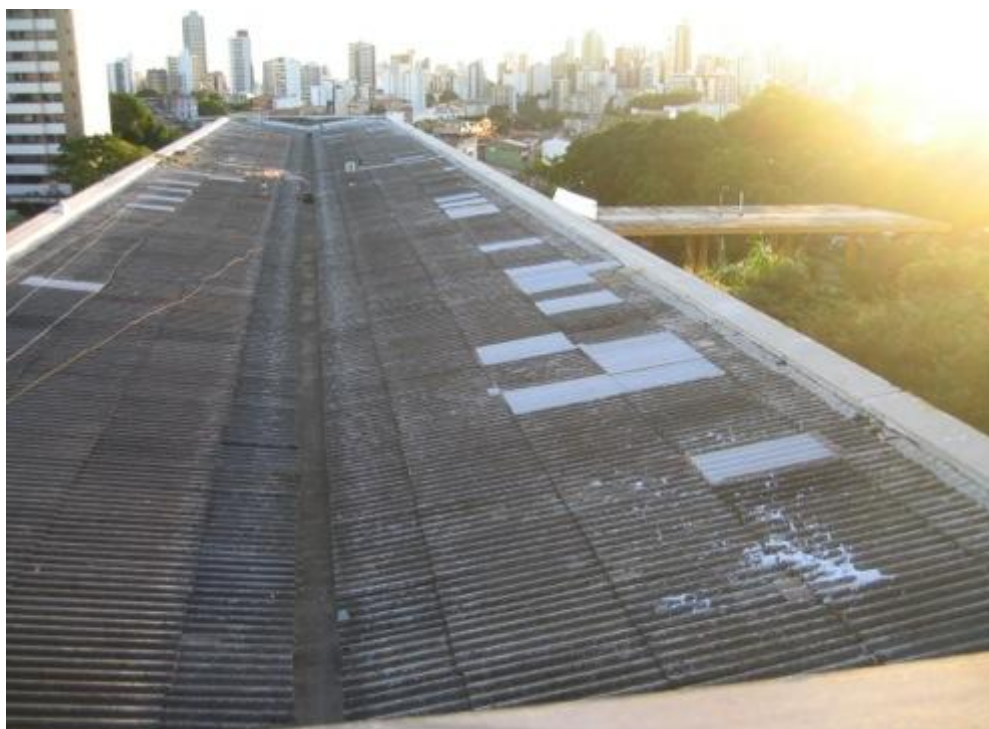
Figura 62. Telhados de fibro-cimento das coberturas C4 e C6, no andar 8, e laje de concreto sobre as escadarias da entrada principal (cobertura C5).
