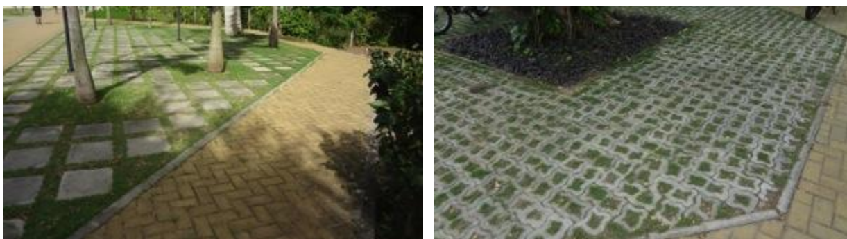
Figura 35. Instalação de pisos e calçadas permeáveis no Campus de Ondina - UFBA, após as obras de reforma de 2012/2013.
