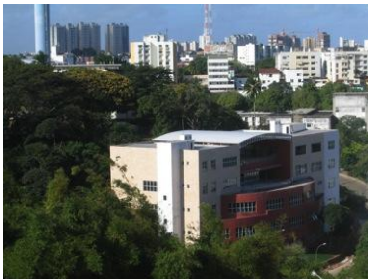
Figura 34. Prédio novo no Campus de Ondina – UFBA, com boas condições para a captação, reserva e distribuição por gravidade de água de chuva.
