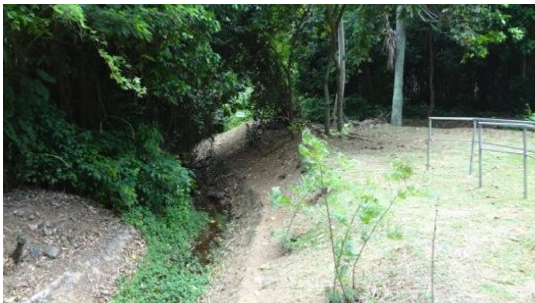
Figura 71. Canal de drenagem que atravessa o Campus de Ondina - UFBA
