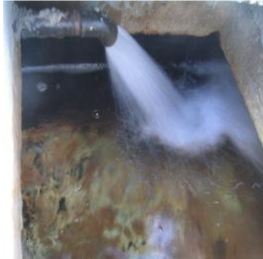
Figura 74. Chegada da tubulação de recalque de água no reservatório superior.
