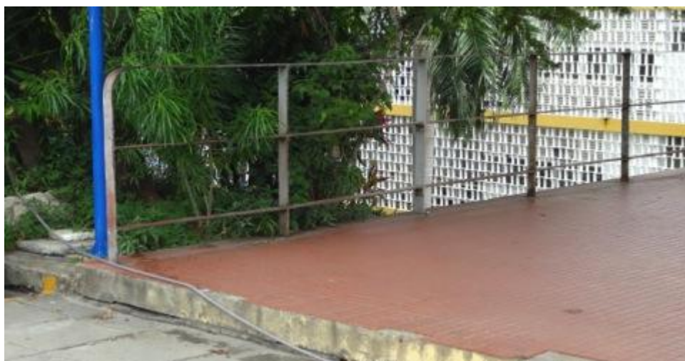
Figura 94. Rega de jardins na parte dianteira do prédio principal.
