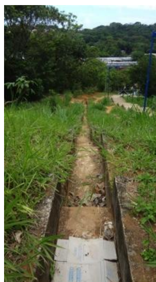
Figura 69. Vistas do bueiro de saída e da escada drenante que percorre a ladeira em direção à parte baixa do Campus (bairro de Ondina).
