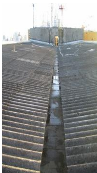
Figura 59. Telhados de fibro-cimento da cobertura C1, no andar 8.
