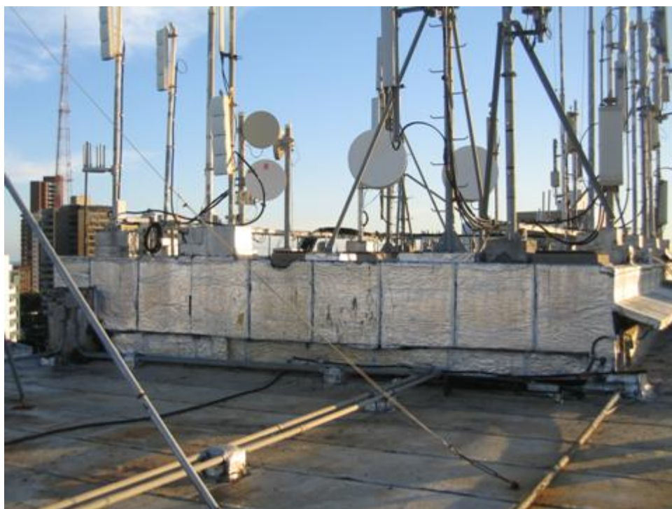
Figura 44. Vista do reservatório superior.
