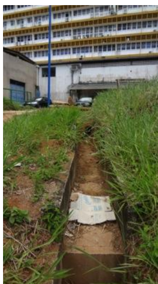
Figura 69. Vistas do bueiro de saída e da escada drenante que percorre a ladeira em direção à parte baixa do Campus (bairro de Ondina).
