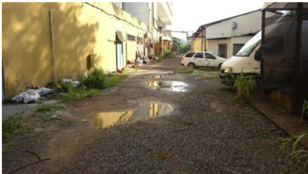
Figura 8. Áreas com alagamento após uma tormenta. Pátio de laboratórios.
