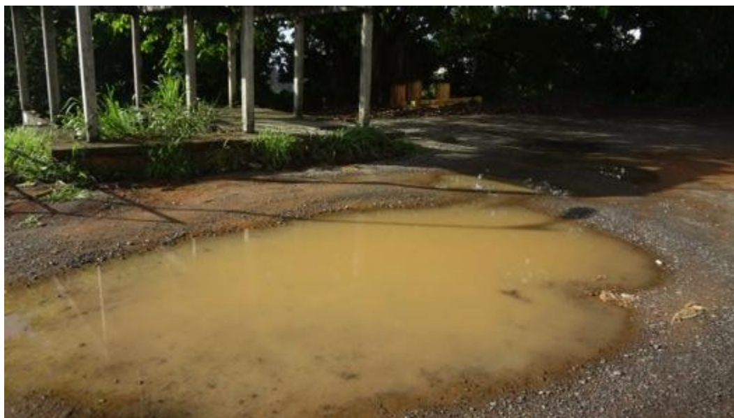
Figura 6. Áreas com alagamento após uma tormenta. Estacionamento inferior.
